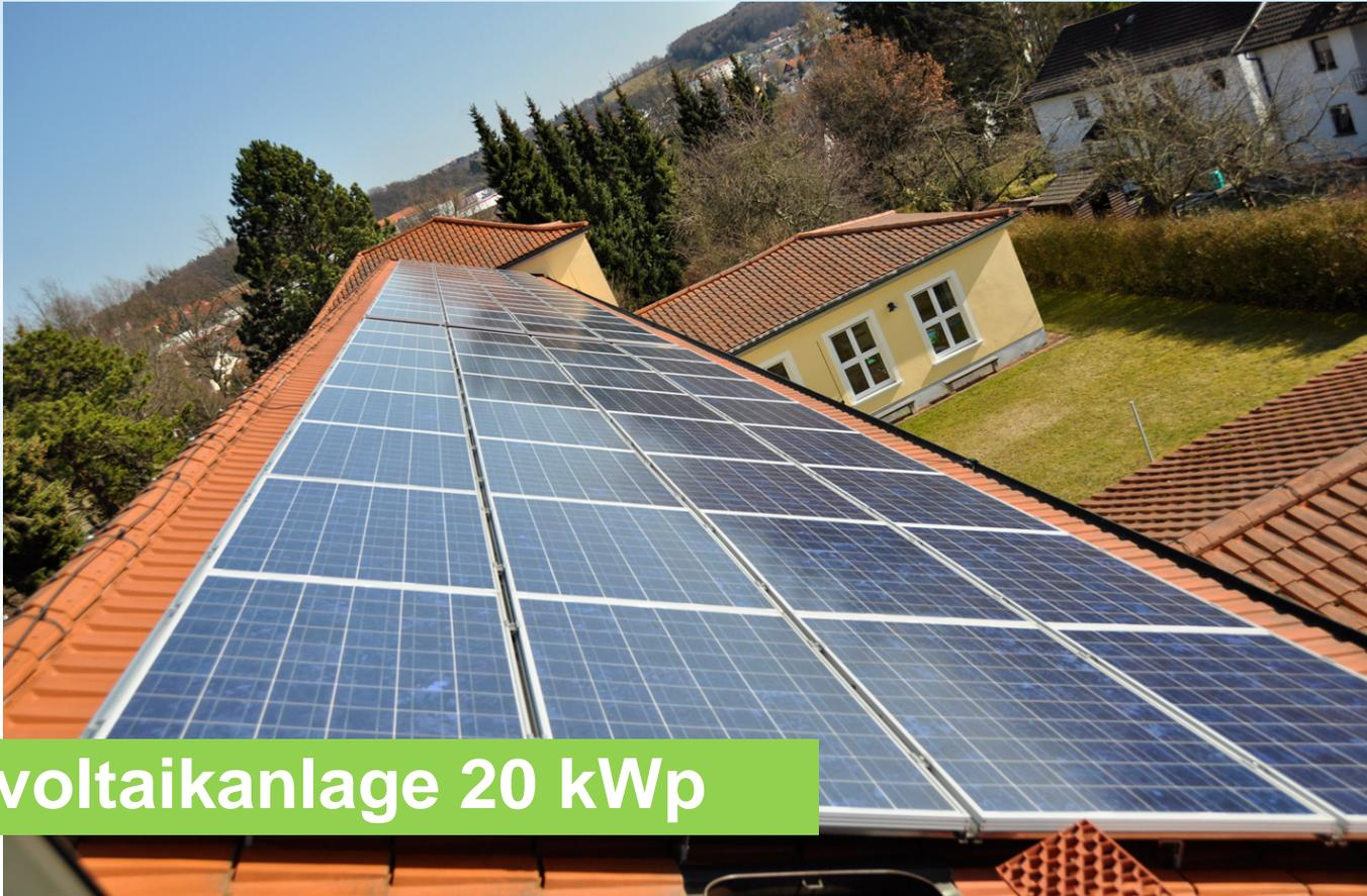
Photovoltaikanlage 20 kWp
